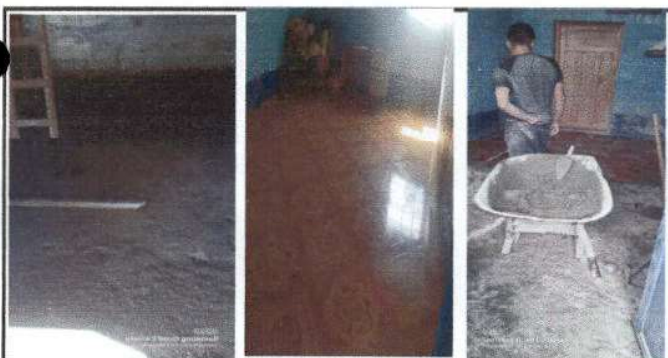
Foto 5: sustitución de torta de cemento por cerámico en cocina, dirección y aulas 1 y 2 por estar en mal estado.
