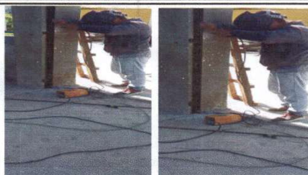
Foto 2: sustitución de portón por oxido y deterioro.
