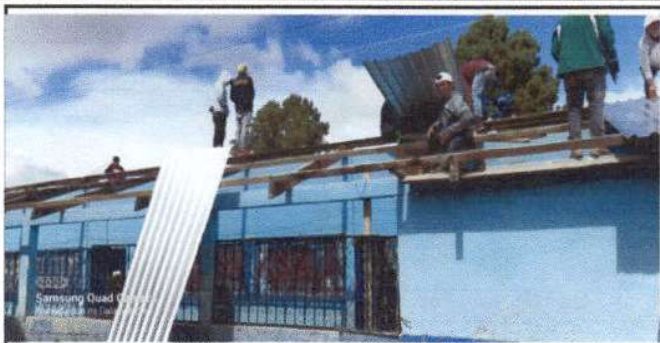
Foto1: Sustitución de lámina por oxidación y filtración de agua en tiempo de lluvia. En aulas 3, 4, 5, 6 y 7.
